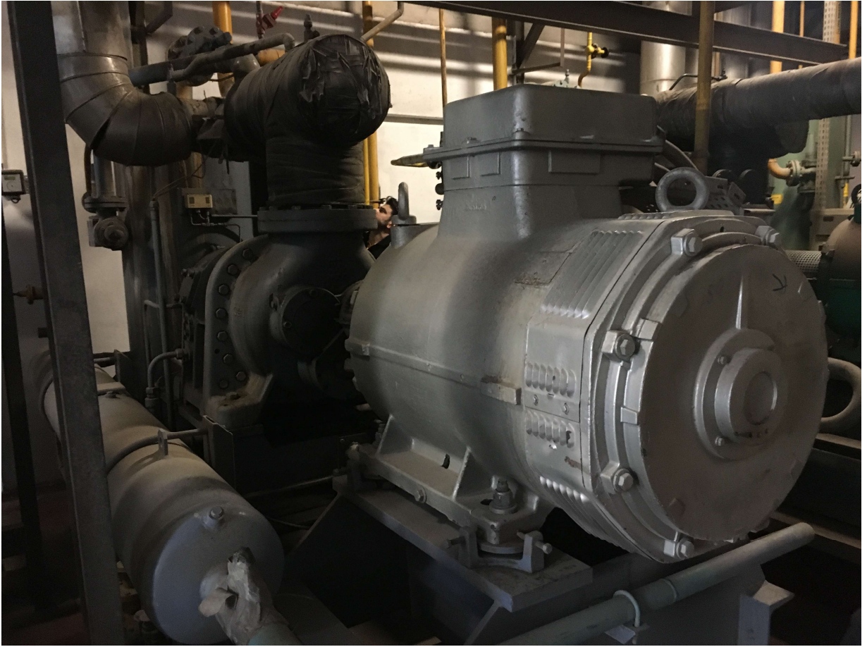
Şekil 1: Motor-Kompresör takımı
